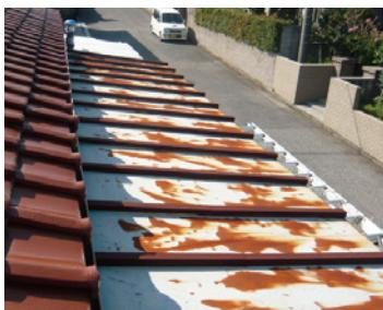
■ Check! ③ 屋根表面に傷がある・錆びている
