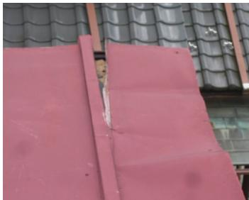
■ Check! ① 屋根材が浮いている・剥がれている
